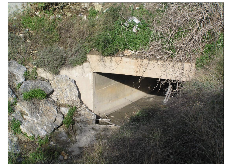
F4 Sección obra de drenaje transversal aguas abajo
