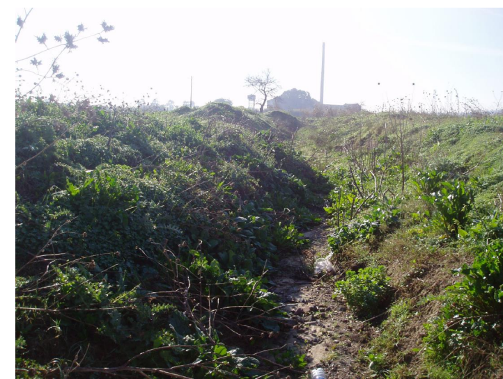
F3 Sección cauce aguas abajo
