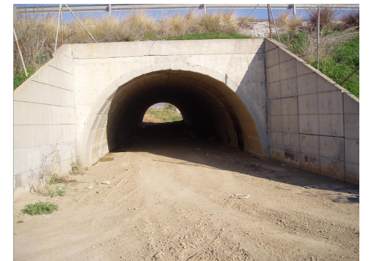
F2 Sección de obra de drenaje transversal aguas abajo
