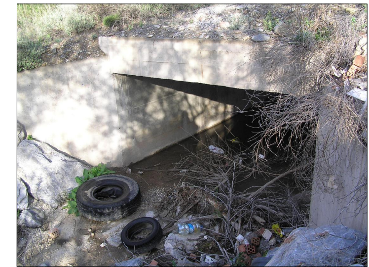
F1 Sección obra de drenaje transversal aguas abajo
