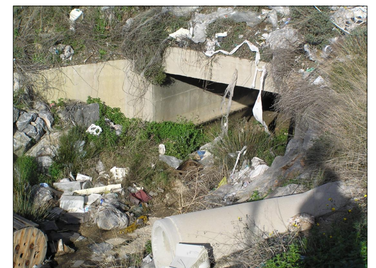
F4 Sección obra de drenaje transversal aguas abajo
